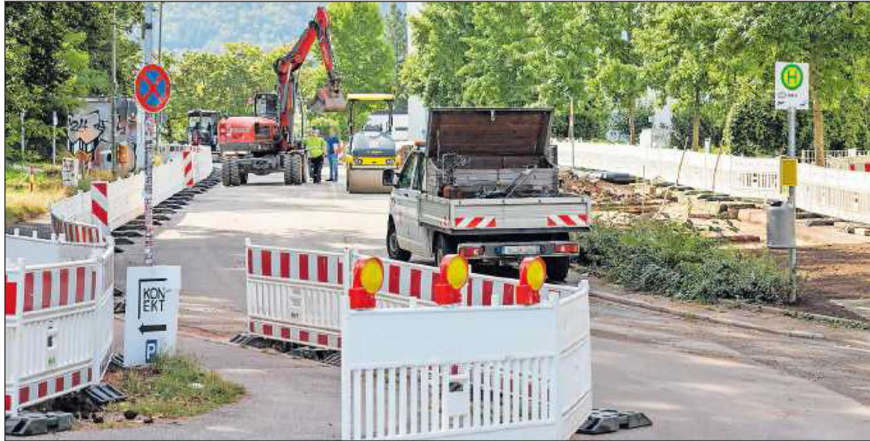
In der Hegelstraße wird zwischen „Zum Betzenberg“ und der Einmündung zur Leibnizstraße am Fernwärmenetz gearbeitet.
