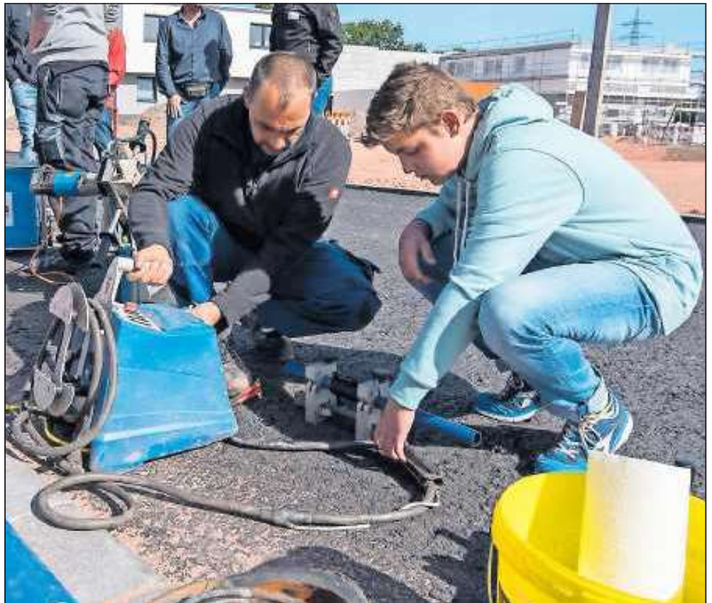
Was es beim Rohrleitungsbau zu beachten gilt, erklärt hier Joachim Flickinger (links) dem 15-jährigen Pascal Jung.
